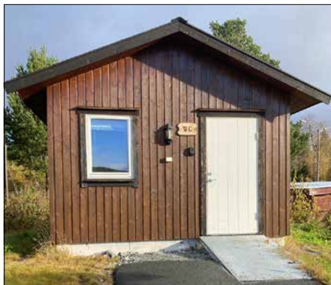
Toalettbygget ble ferdig like før åpningen av rulleskiløypa høsten 2014, og hadde en kostnad på ca. 800 tusen.
