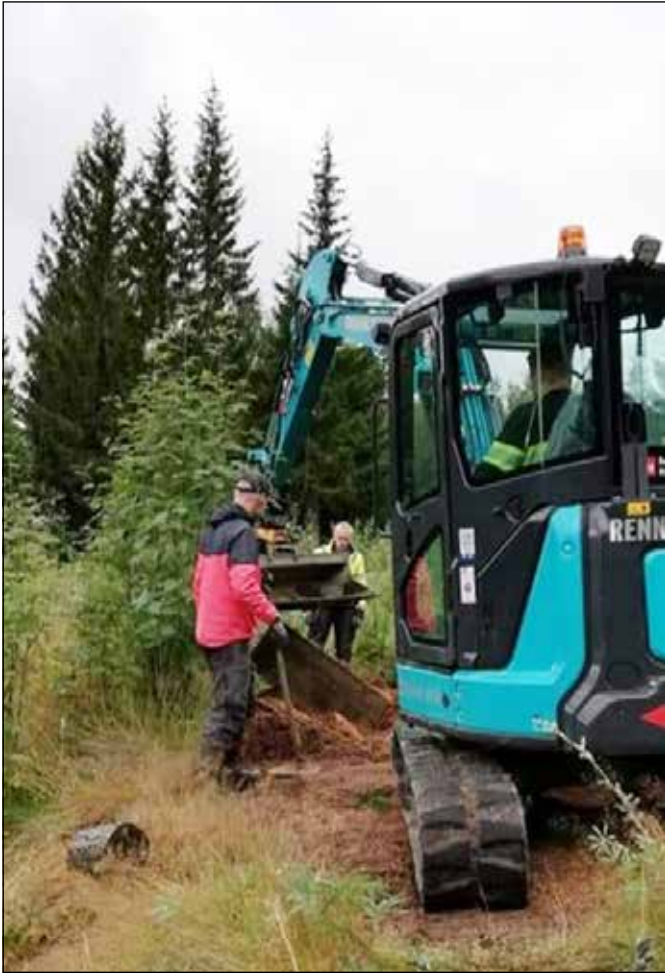
Fundamentene på 1000 - 1500 kg graves opp. Håvard Rogogjerd og Oddvar Myrmo følger spent med.
