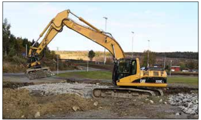
Andreas i gang med å fylle rundt fundamentene.
